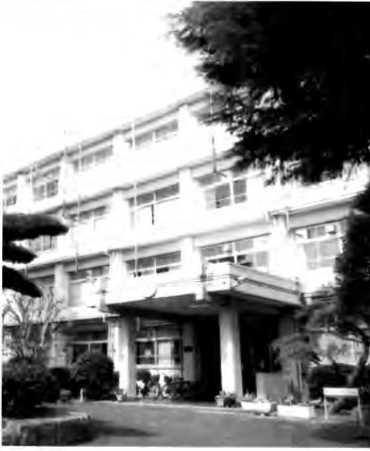
大規模耐震工事が計画されている厚高校舎1棟
