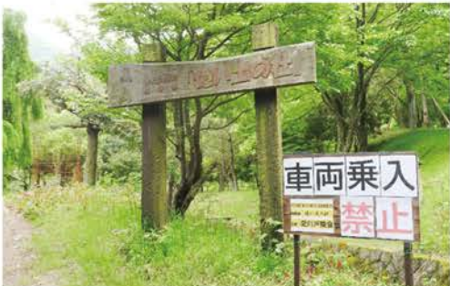
△車両乗入禁止看板 『憶い出の杜』に車を乗入れる方がいるため、「車両乗入禁止」の看板を立てて出入口斜面の崩壊防止対策をしました。
